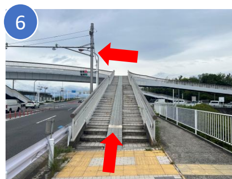
6 歩道橋を上がり、左折
